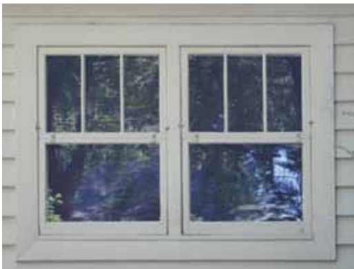
Fenêtre double à guillotine avec fenêtre amovible à l'extérieur et pied-droit.
