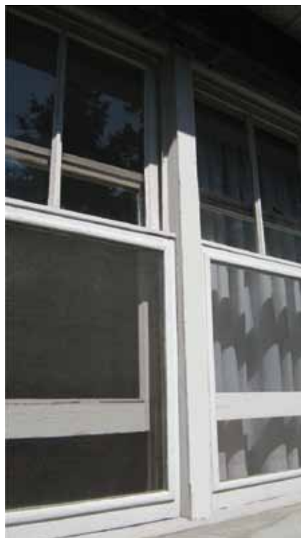
Fenêtre double à guillotine avec fenêtre amovible à l'extérieur et pied-droit.
